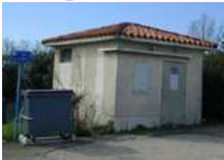
Le poste EDF
